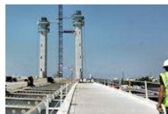
2011 les pylônes sont établie
