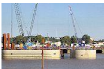
2010 débuts des travaux
